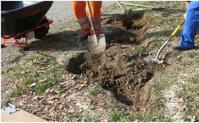
Grasnarbe entfernen, Mulde ausheben.
