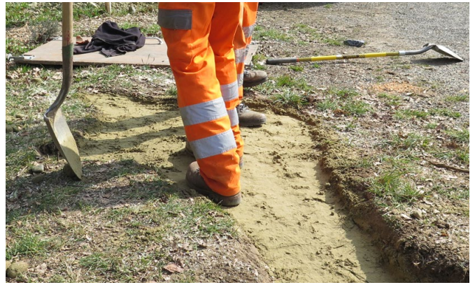
Kompakt mit Sand auffüllen.
