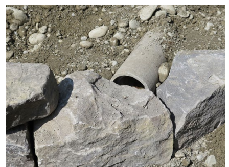
In die Trockenmauer sind Hohlkammern unter anderem für Hummeln eingebaut.
