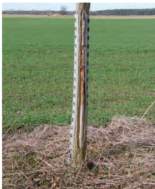
Abb. 7: Vergessen! Fehlende Hinterlüftung einer auf der Rinde aufliegenden Plastemanschette führt zur deutlichen Temperaturerhöhung und einem Rindenschaden. Das Risiko ist höher als auf der ungeschützten Rinde! Foto: Jeschke (links und rechts)
